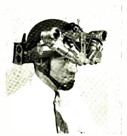
Fig. 12-Type Z Helmet Binocular.
