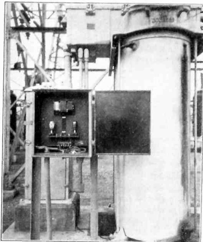
FIG. 5—DOUBLE UNIT OUTDOOR AMPLIFIER
