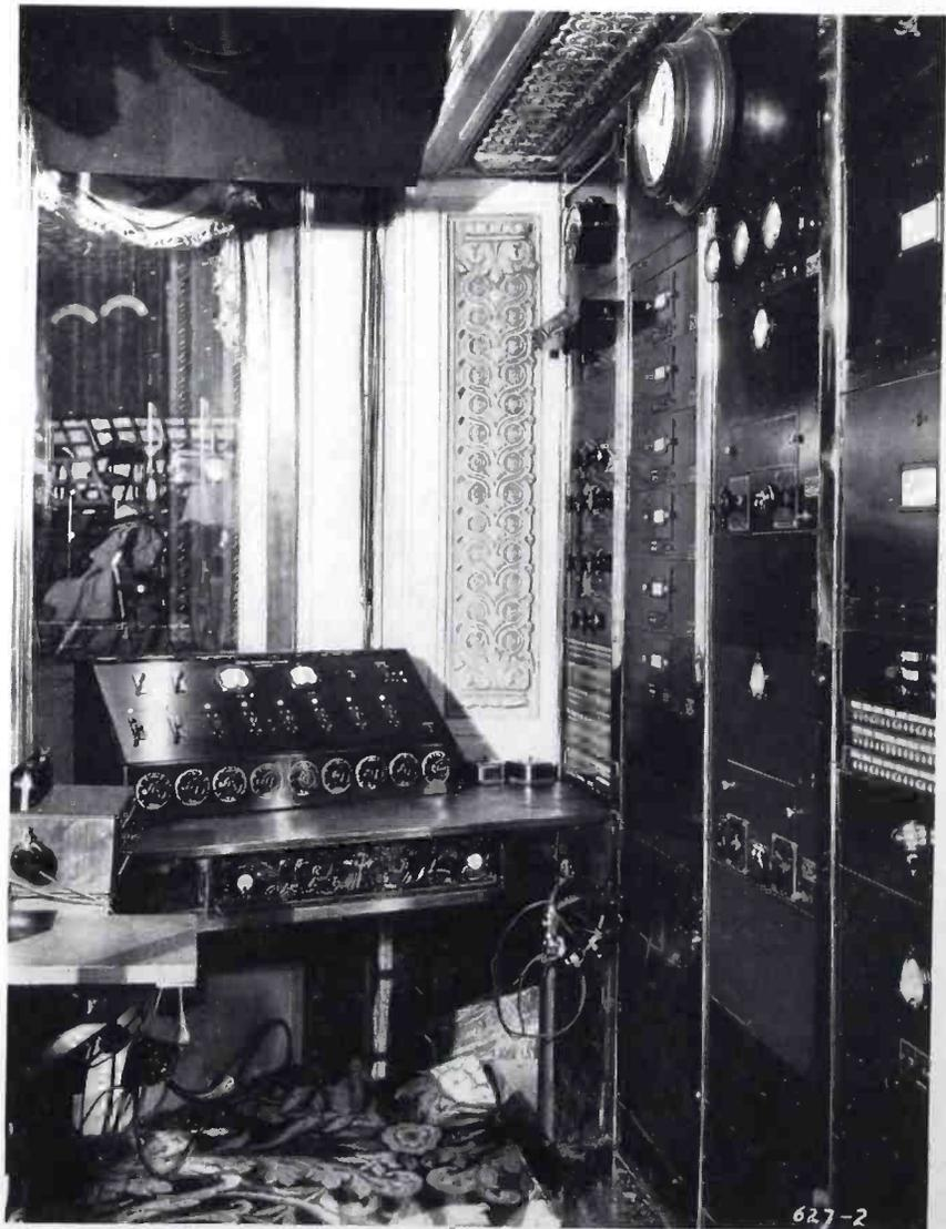
A CLOSE-UP IN THE CONTROL ROOM OF THE COLUMBIA RADIO PLAYHOUSE SHOWING THE MIXER CONSOLE AND EQUIPMENT RACKS. RCA VICTOR STUDIO EQUIPMENT EMPLOYED
