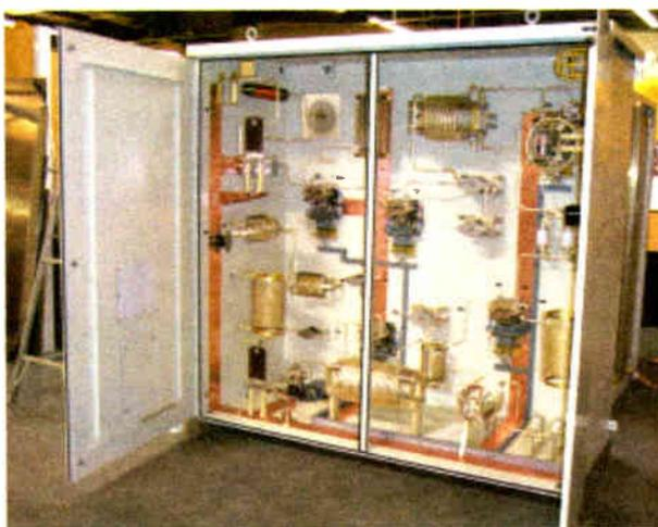
**DIRECTIONAL ARRAY ANTENNA TUNING UNIT**
