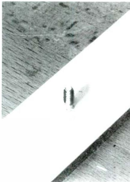
**PHOTO 8:** Installed hanger bolt.
