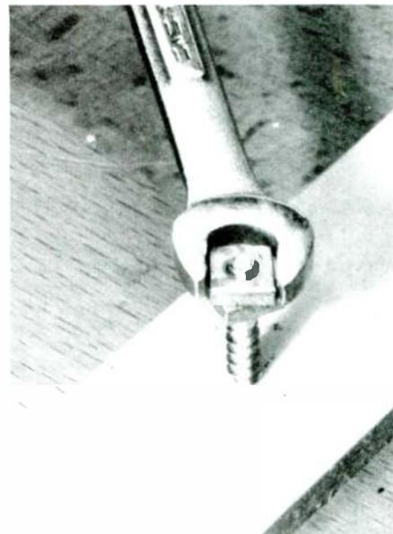
**PHOTO 7:** Installing a hanger bolt.
