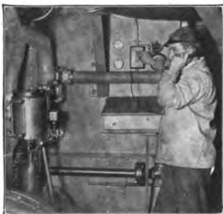
FIG. 2—THE INTER-PHONE IN THE ENGINE-ROOM.
