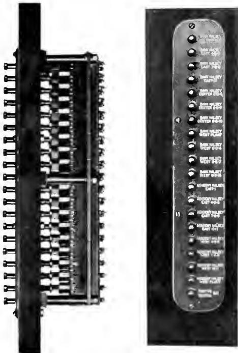
Fig. 4. Push Button Voltmeter Switch
