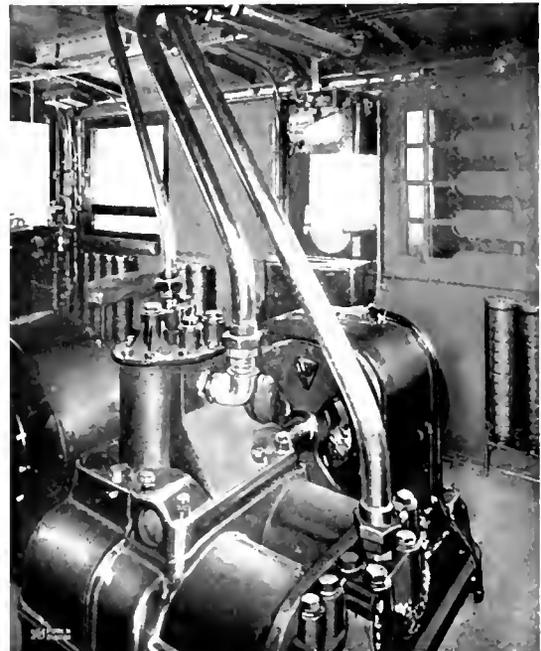
Fig. 14. Motor-Driven Air Compressor
