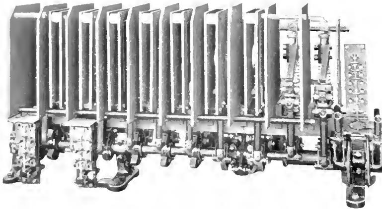
Fig. 14. 2400-Volt Series-Parallel Switch
