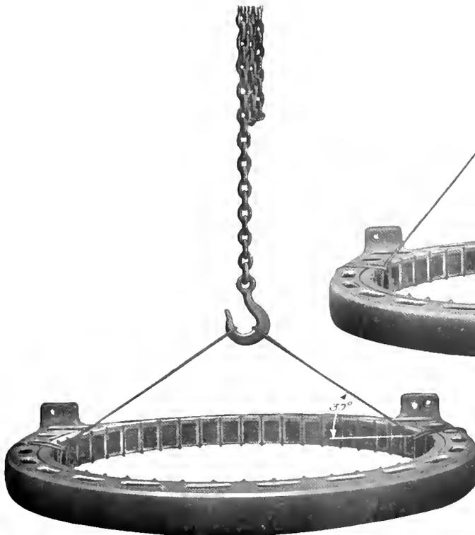
Fig. 27. 30 Deg Angle Sling (Wrong Way)
