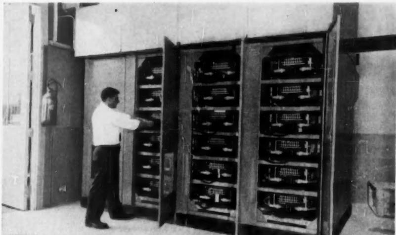
GERMANIUM RECTIFIER DELIVERS 1950 KW OF DIRECT CURRENT AT 94 PERCENT EFFICIENCY.
