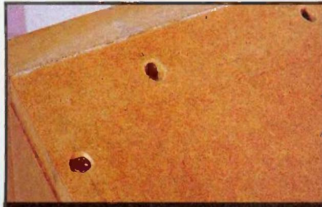
Détail des vis de la partie inférieure, celles allant vers la face avant sont inclinées à 45°.
