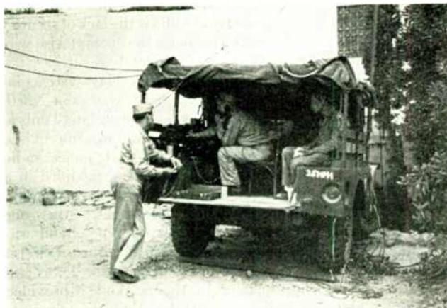
MOBILE FM TERMINAL STATION IN TRUCK COULD MOVE QUICKLY TO NEW LOCATION AS BATTLE LINES CHANGED
