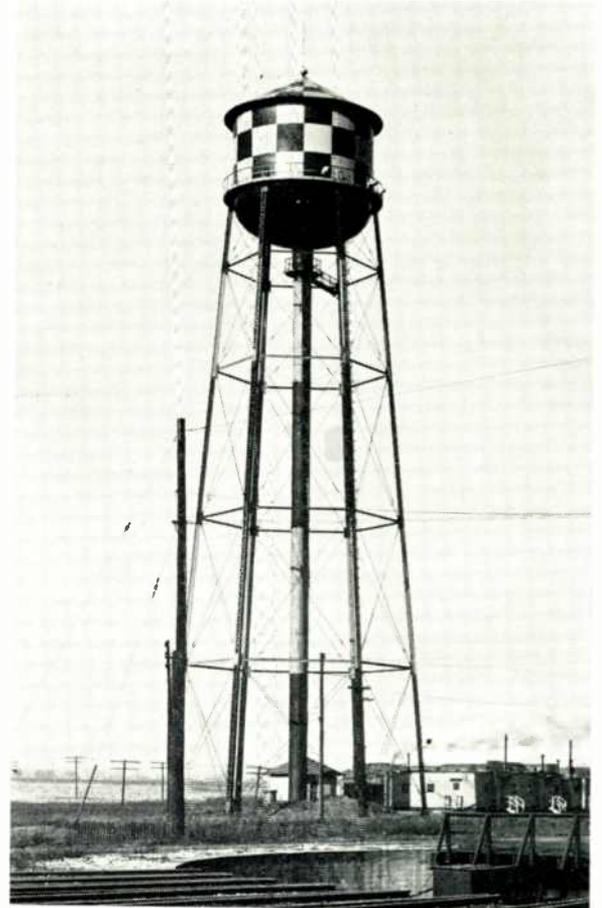
FIG. 5. MAIN STATION ANTENNA ON THE WATER TOWER AT THE FLAT ROCK END OF THE SYSTEM
