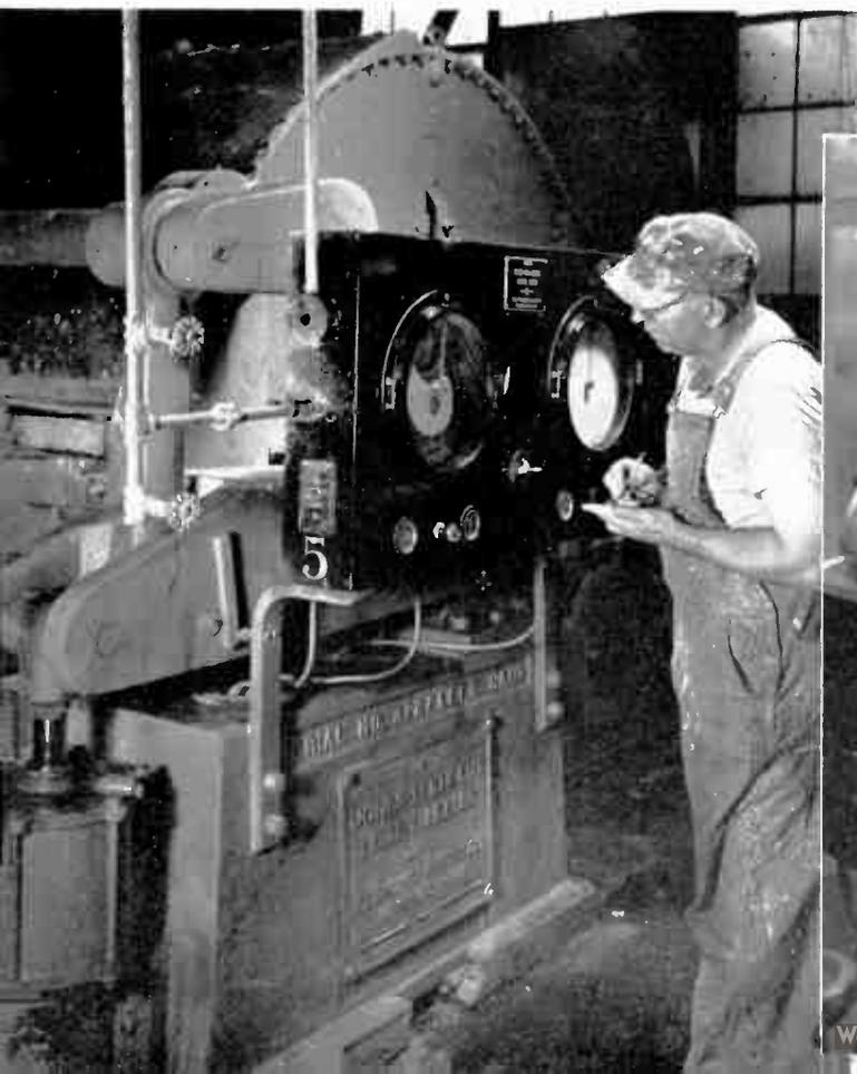
FIG. 7. UNIFORM BEATING OF EACH BATCH OF STOCK IS ASSURED BY RECORDING INSTRUMENTS WHICH SHOW THE BEATER ACTION
