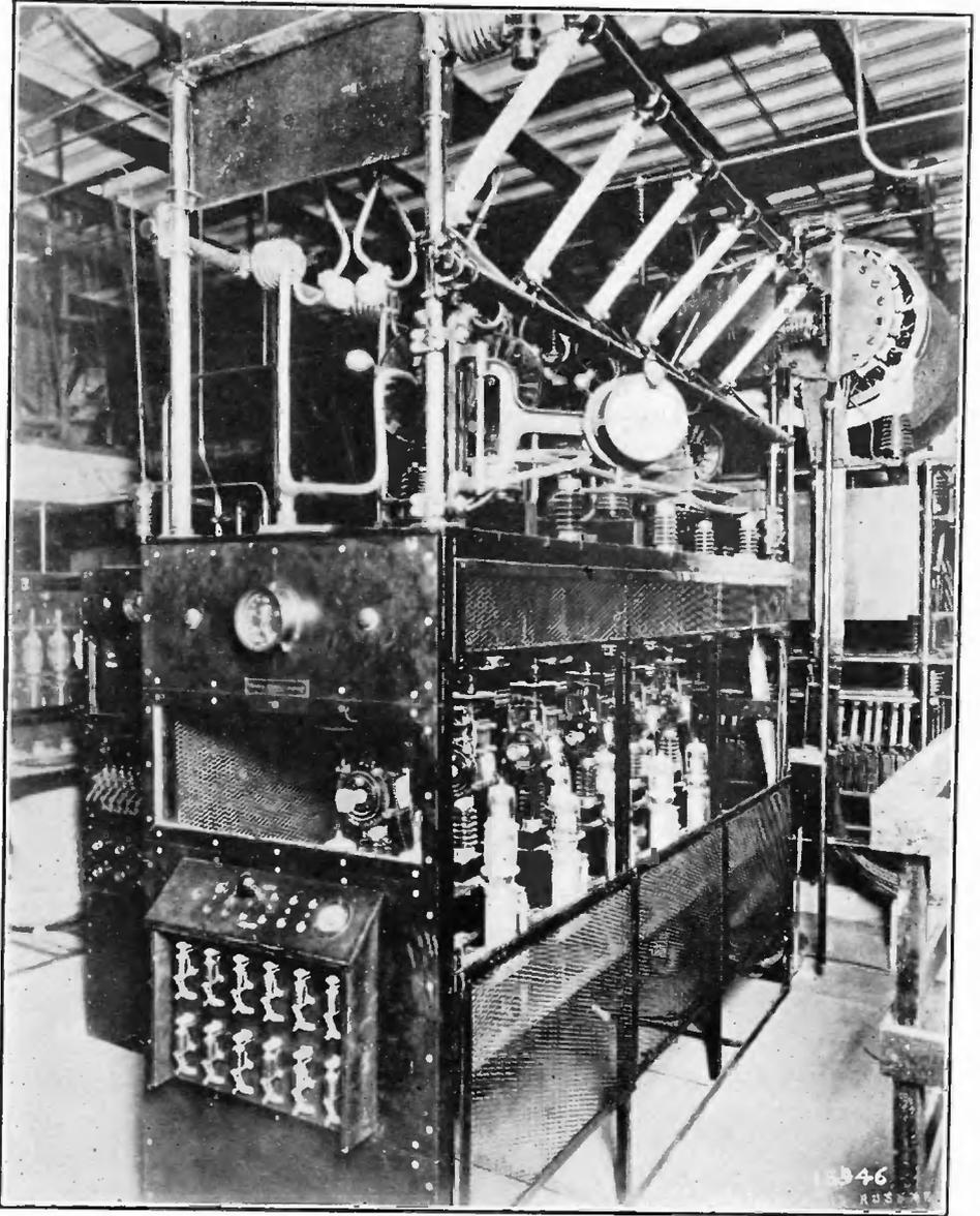
FIGURE 32—Six-phase Rectifier
