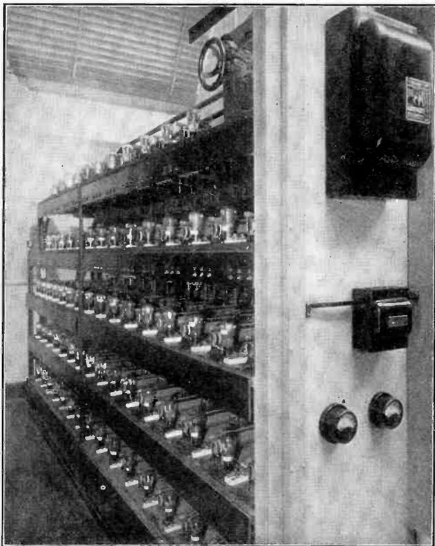
Fig. 24—Hot Cathode Rectifier Life Test Rack.
