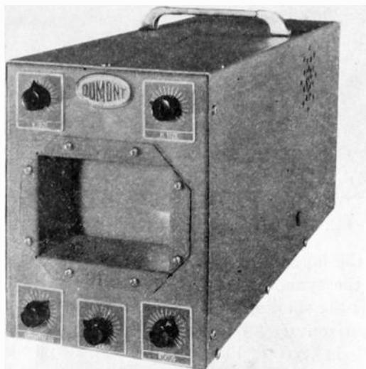
Fig. 12—Camera-monitor unit.
