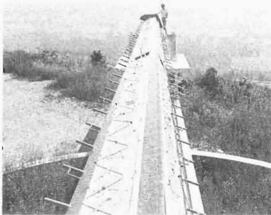
Fig. 75. GE Zig-Zag Antenna.
