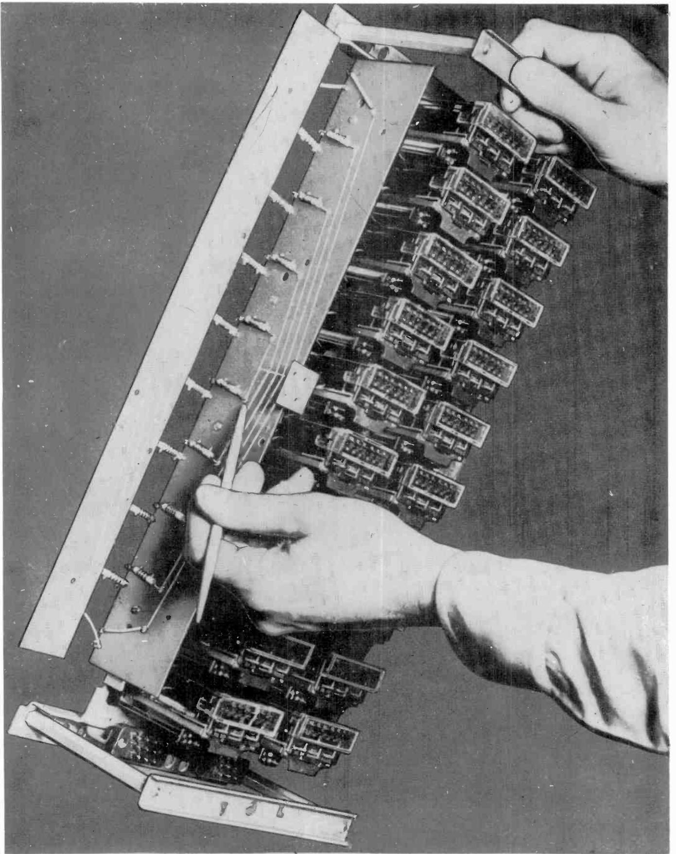
10X1 VIDEO SWITCH MULTIPLE WIRING
