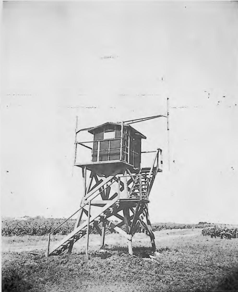
TYPICAL RID MANUALLY OPERATED HIGH FREQUENCY ADCOCK DIRECTION FINDER AS USED BY RID
