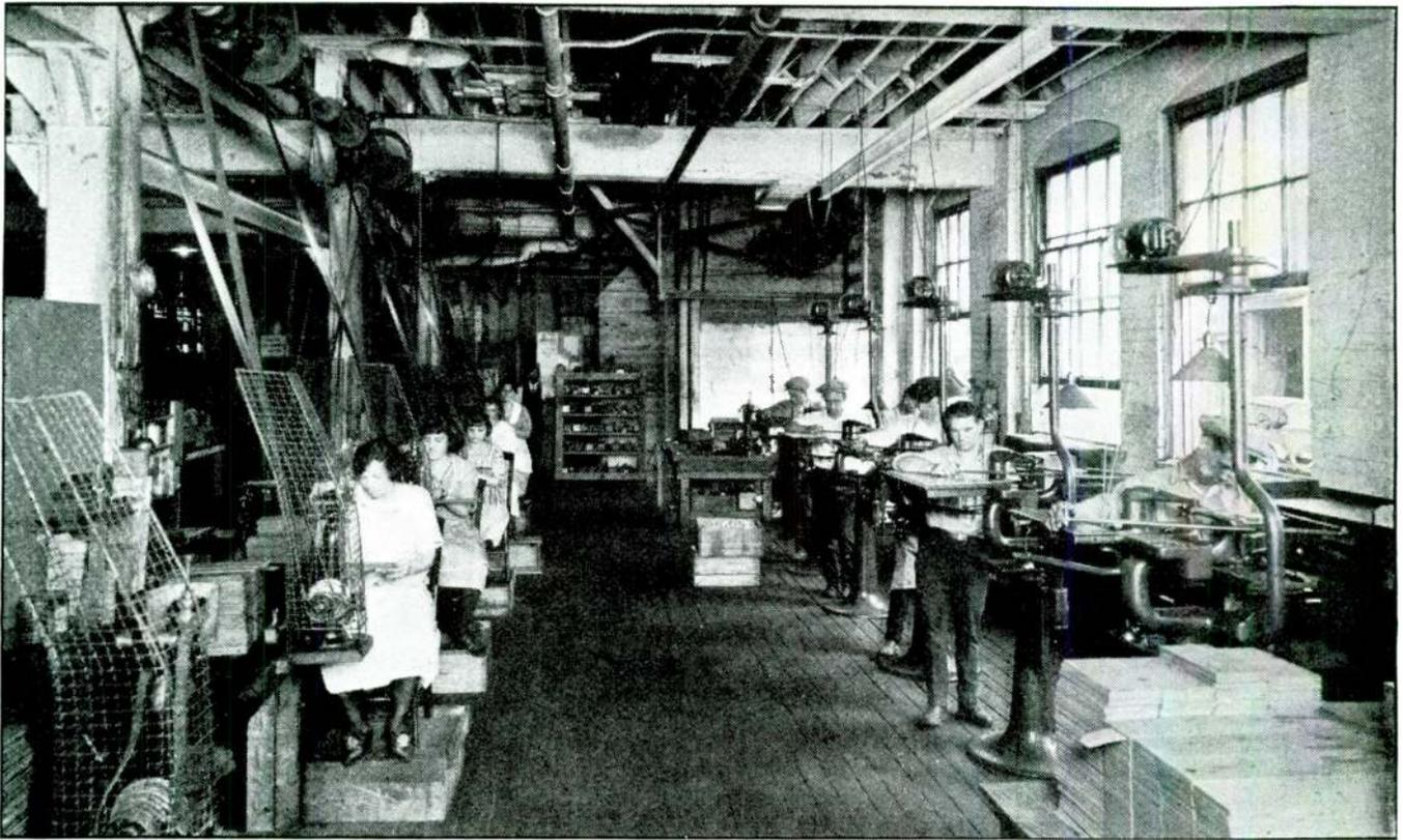
ENGRAVING AND FINISHING PANELS FOR FOUR-TUBE RECEIVERS
