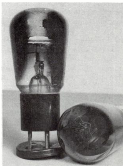
Fig. 21-23. Telefunken RGN354 tube.
