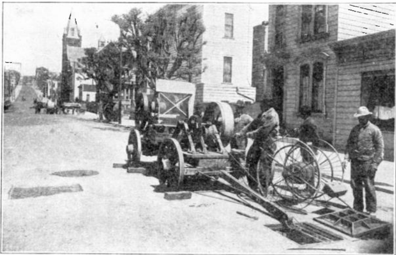
Fig. 602. Cable Pulling Apparatus
