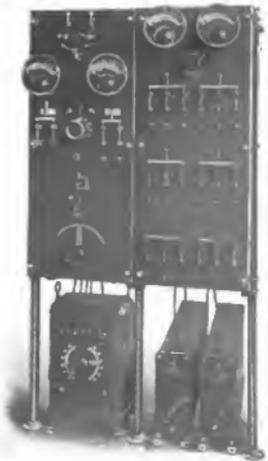
Fig. 2. Mercury Arc Rectifier Automobile Garage Outfit
