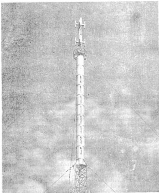
FIG. 23.—HIGH-POWER TELEVISION TRANSMITTING AERIAL USING FOLDED DIPOLES.
