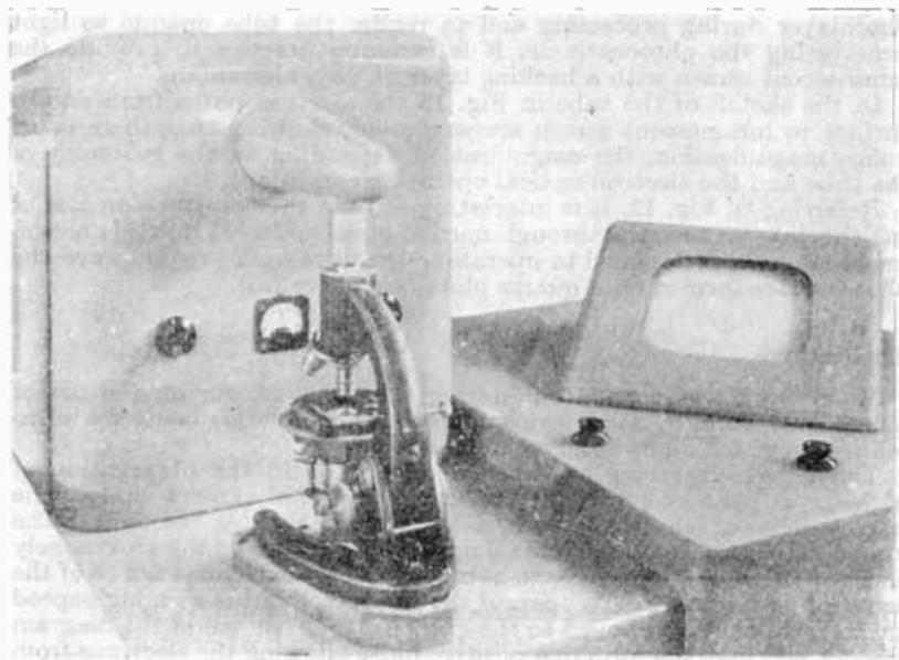
FIG. 14.—FLYING-SPOT MICROSCOPE.
