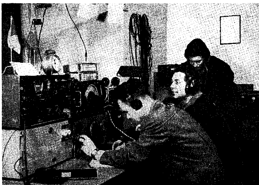
Záběr z kolektivní stanice OK 1 KUR
