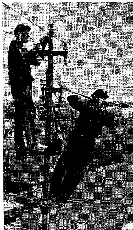
Stavba sítě rozhlasu po drátě v Unhošti.
