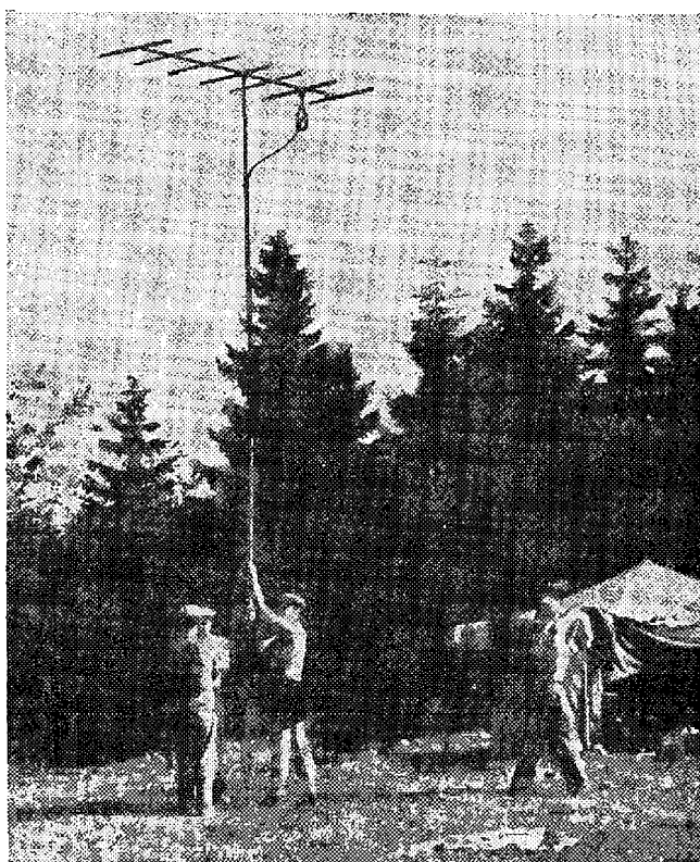
Stavba antény na 145 MHz na stanici UB5KMX.
