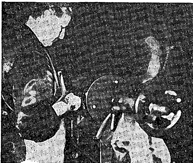
U standartních desek se přetok oláme a okraj se osoustruží
