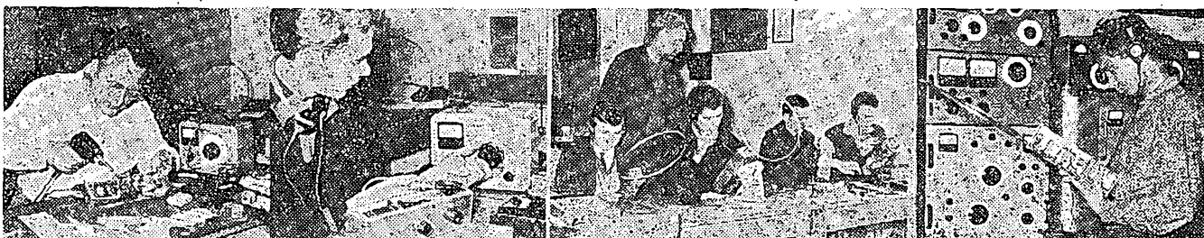
Na obr. zľava: Súruh Greško dokončuje zapojenie prijímača; s. Bohuš pri zladovaní prijímača pre lov na lišku; posledné úpravy pred skúškou v teréne; meranie citlivosti prijímača pre lov na lišku
