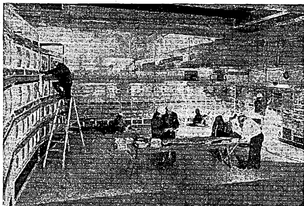
Obr. 1. Pohled do televizního velínu OH. Vlevo stěna se 48 monitory, vzadu a upravo část stojanů pro zvukové zesilovače
