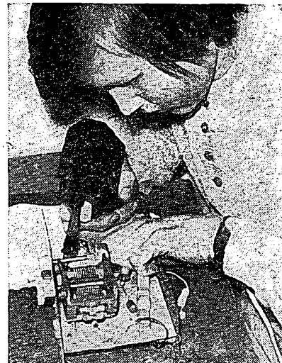
Mezi příkladné členy radiokroužku patří také Jiří Váňa, který je zachycen při stavbě zpětnovazebního přijímače
