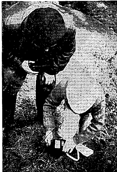
Obr. 7. Měření zemního odporu Megmetem
