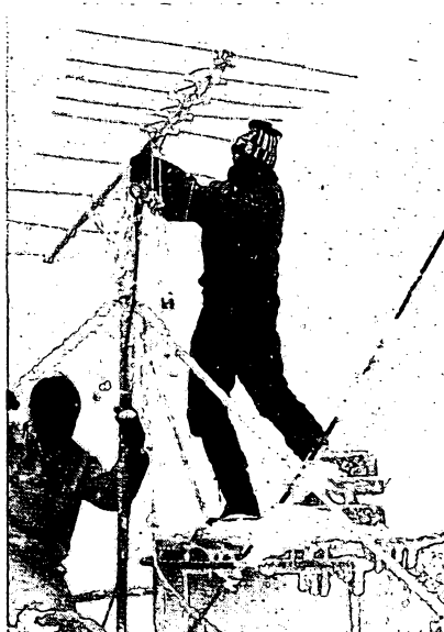
Obr. 1. Záber uprostred leta jasne naznačuje, že vo výške 2663 m n. m. nebolo núde o sneh a ľad. A preto, aby anténa SWAN smerovala, bol nutný túto akrobatskú polohu OK3UQ opakovat pravidelne každú polhodinu. Najväčšie problémy boli s udržiavaním sa na streche pri 100 km nárazovom vetre
