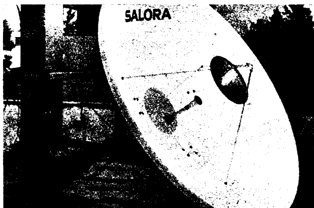
Obr. 14. Umístění antény typu Cassegrain o průměru 180 cm na betonovém sloupku, který je součástí střešní konstrukce
