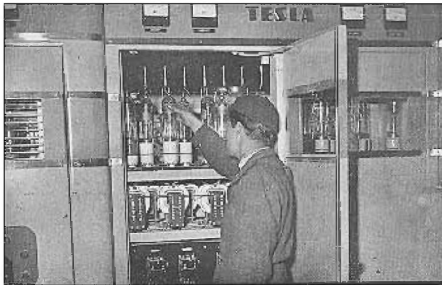
Výkonové stupně televizního vysílače Praha - Petřín v roce 1953
