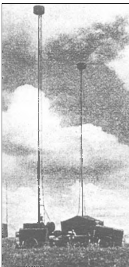
Obr. 6. Trychtýřová anténa s horizontálním a vertikálním dipólem (nahore); na snímku dole táž anténa na teleskopickém stožáru
