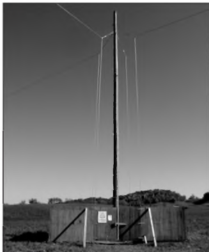
Obr. 2. Prototyp antény Kinstar pro 1680 kHz
