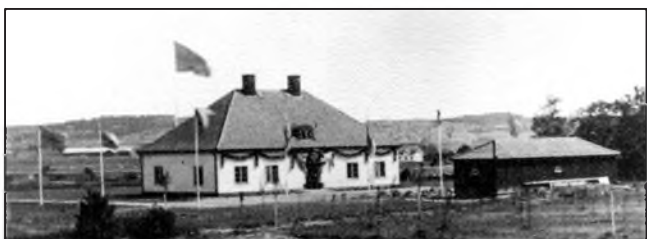
Stanoviště přijímací stanice v Kungsbacku (vlevo)
