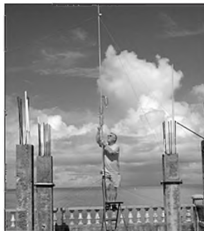
Roger C21SX nastavuje vertikální anténu typu HF6V na střeše hotelu
