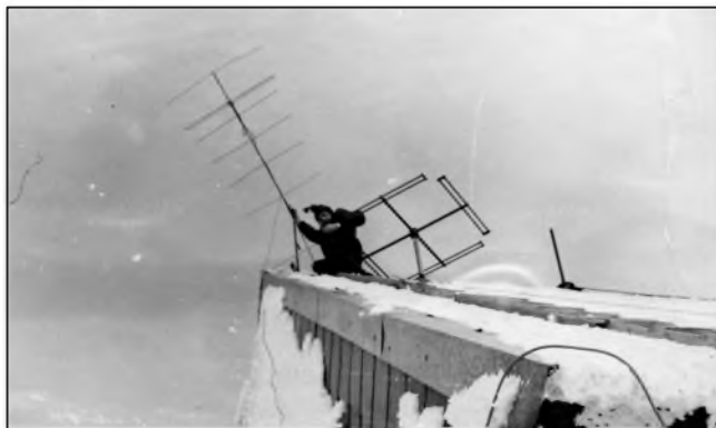
Obr. 3. V popředí Franta, OK1AIB, při montáži směrové antény pro závod v pásmu 2 m na České boudě. V pozadí všesměrová vysílací anténa převaděče OK0A (1975)
