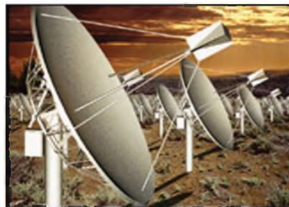
Obr. 4. „Allen Telescope Array“ (ATA), pole 350 parabol o průměru 6,1 m, které bude mít po dokončení úhrnnou sběrnou plochu 1 hektar (odtud dřívější označení 1hT) a rozlišovací schopnost 20 úhlových vteřin v rozsahu 1 až 12 GHz. Viz http://ral.berkeley.edu/ata/
