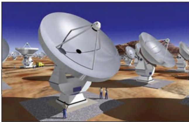
Obr. 3. Projekt ALMA se soustavou 64 pojízdných teleskopů s parabolickými anténami o průměru 12 m v chilské poušti Atacama (viz text)
