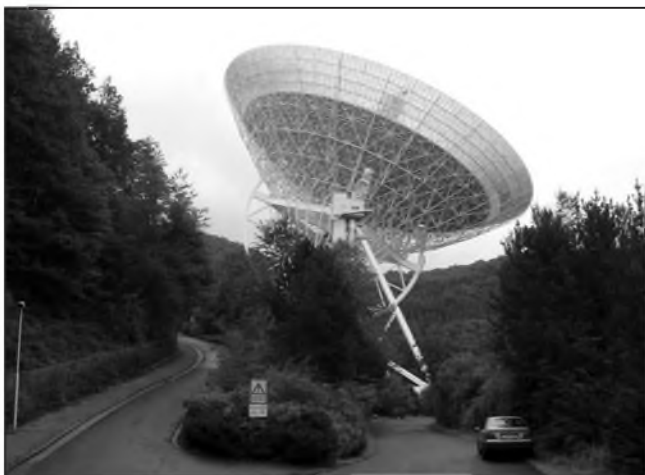
Obr. 5. Nám nejbližší obří radioteleskop o průměru 100 m a váze 3200 t v německém Effelsbergu s úhlovým rozlišením 9,4 " na 1,4 GHz až 10 " na 86 GHz, viz http://www.mpifr-bonn.mpg.de/div/effelsberg/index_e.html
