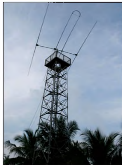
Obr. 4. Věž s tříprvkovou směrovkou Stepp-IR
