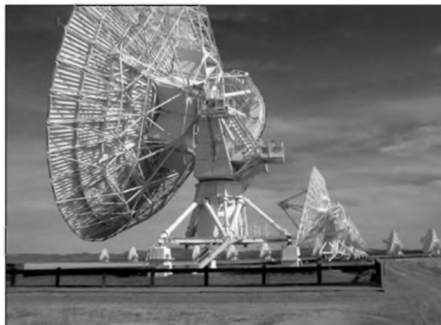
Obr. 6. Very Large Array se skládá z 27 antén o \varnothing 25 m, rozložených ve tvaru Y na pláni u San Agustino, 50 mil západně od Socorro v Novém Mexiku, viz http://www.nsf.gov (National Science Foundation a fotograf K. Armendariz)
