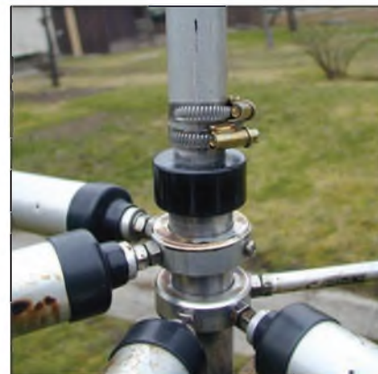
Obr. 6. Zpevnění spojů antény hadicovými spojkami
