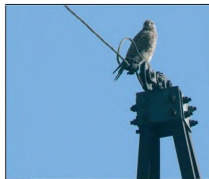
Obr. 2. Zábrana BIRD RING je z izolantu a montuje se na již existující vedení vn
