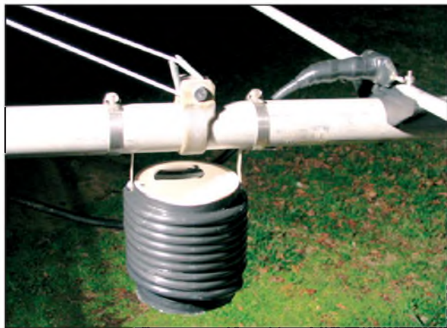
Obr. 6. Praktické provedení proudového balunu a jeho umístění v blízkosti napájecího bodu zářiče
