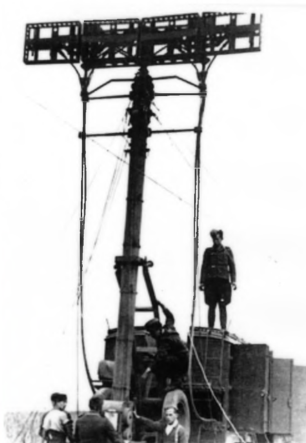
Antennní soustava na obrovském výsuvném stožáru pro pojítka DMG 7 K - Michael na bojišti v Rusku
