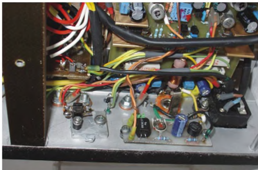
Obr. 114. V zesilovači 100 W jsou na chladič profil připevněny i blok s diodami pro snímání teploty (vlevo) a deska kompresoru s fotoodporem (uprostřed)
