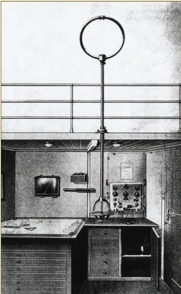
Obr. 10. Novější vybavení stanice gonia (1935) se směrovou otočnou anténou a anténou pomocnou „a“ svísele umístěnou mimo kabinu; vidíme její přívod s anténními izolátory na stěně. Na pracovním stole je navigační trojúhelník, nad stolem námořní dalekohled, uprostřed mechanismus natáčení směrové antény se stupnicí a přímozesilující přijímač E358N se sluchátky.
