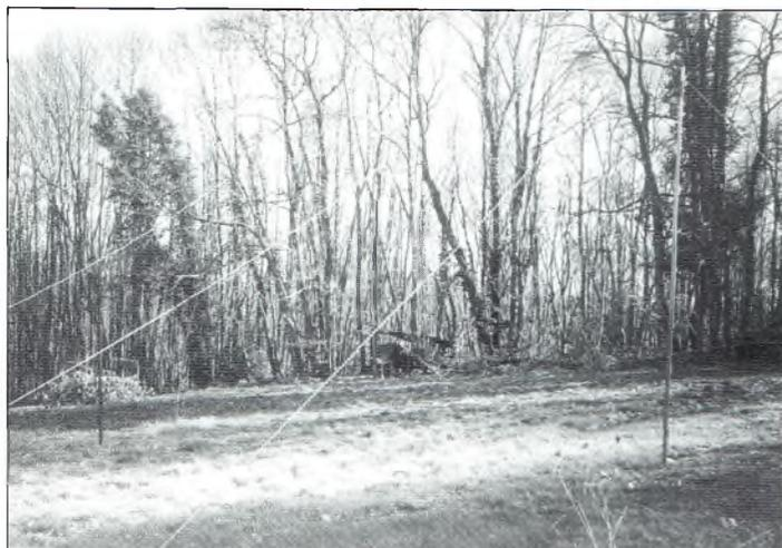
Deux mâts, quelques mètres de fil électrique, et vous voilà équipé d'une Yagi 4 éléments pour le 14 MHz !
