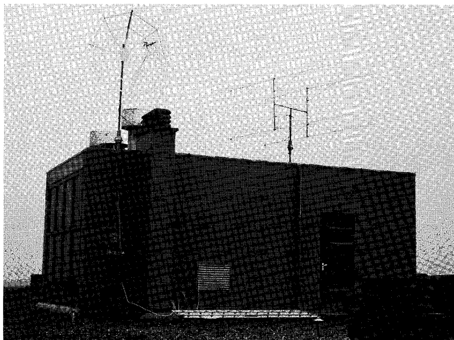
De antenneopstelling boven op een flatgebouw. Een parabolantenne (doorsnede 2 meter) voor 23, 13 en 9 cm. De 4x21 elements Tonna (gestackt) voor 70 cm staat hier rechts op de foto. Op het dak zien we Maarten, PE1DQM.
